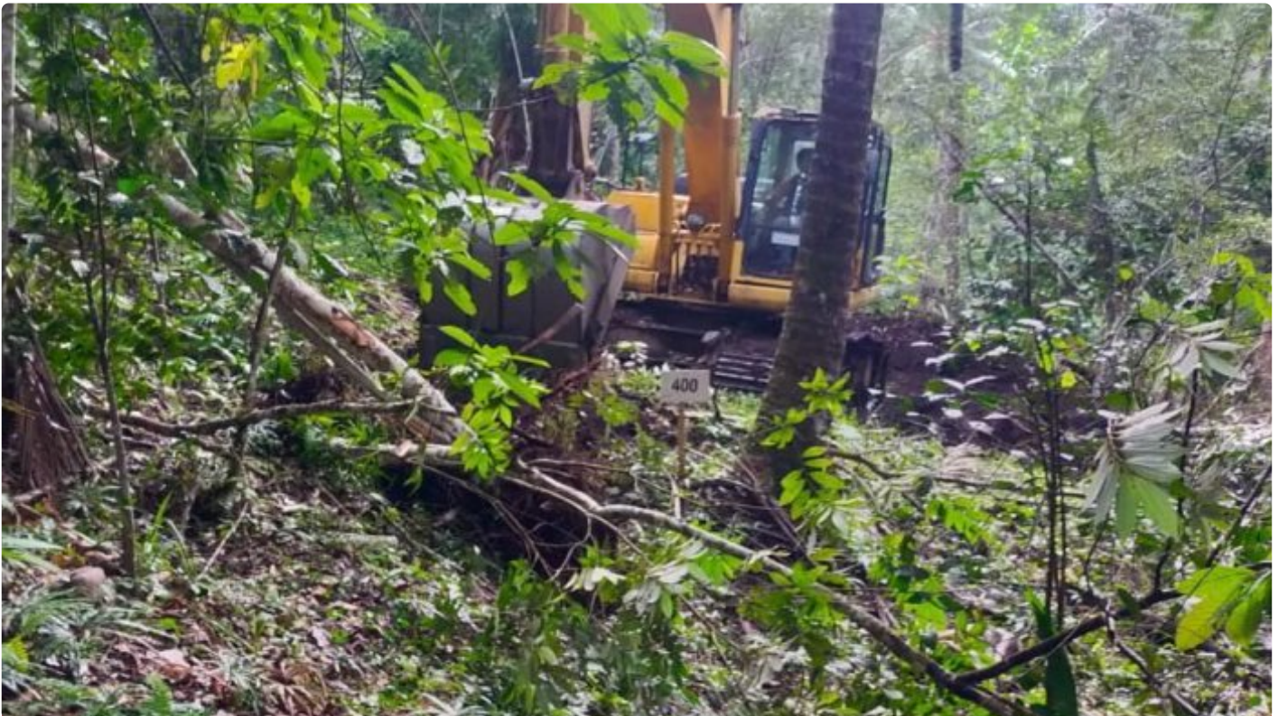
Pekerjaan akses Jalan TMMD Ke-116
